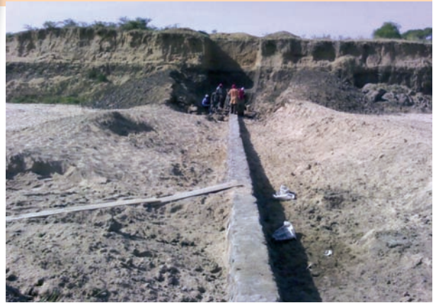
Diga sotterranea a Ariamaoi.
