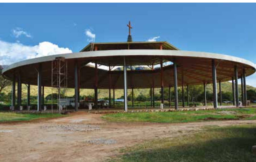
La nuova Cattedrale di Moroto in via di costruzione.
